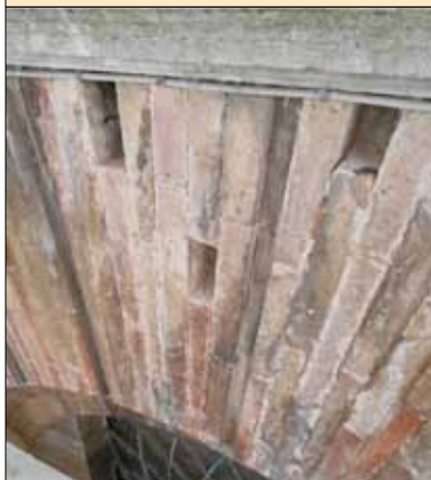
INTEGRAZIONE A TASSELLO degli elementi fortemente degradati con laterizi vecchi delle stesse dimensioni e caratteristiche.
