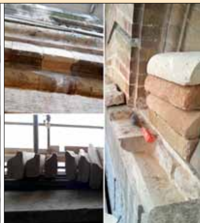
RIPRISTINO DI CORNICI IN MATTONI MODANATI E REFILATI.
