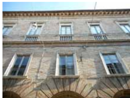
Facciata su Corso Cavour
