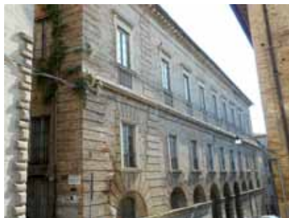
Facciata su Corso Cavour
