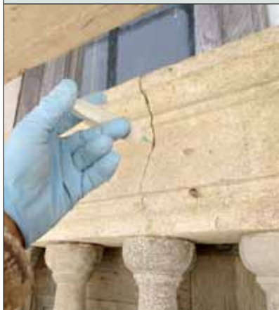
CONSOLIDAMENTO DI SCAGLIE MALFERME O MATERIALE DECOESO
