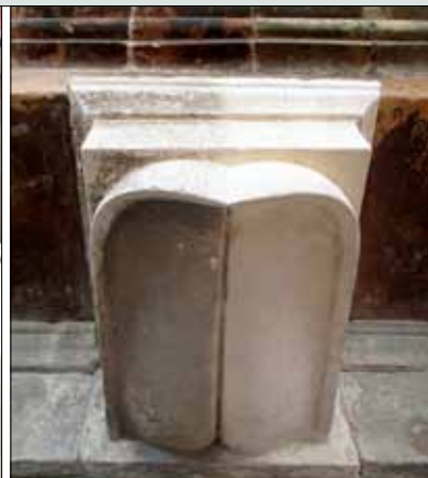
PULITURA mediante impacchi chimici, manuale, con acqua nebulizzata a pressione controllata.
