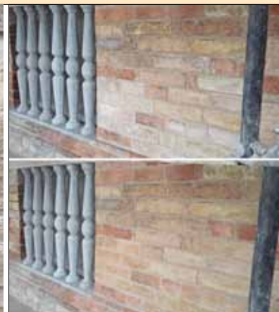
VELATURA CROMATICA di invecchiamento eseguita a pennello con l'utilizzo di terre colorate limitatamente alle sole parti di reintegrazione. A seguire trattamenti protettivi anti-alga, consolidante, idrorepellente.
