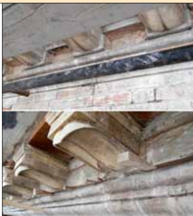
RIPOSIZIONAMENTO ELEMENTI ORIGINARI in cotto precari con integrazione di quelli fortemente degradati.
