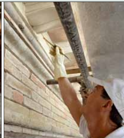
RITOCOCCO A VELATURA CROMATICA DI ACCOMPAGNAMENTO; a seguire trattamenti protettivi anti-alga, consolidante, idrorepellente.
